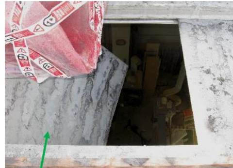
Foto 2: lastra di ondulato plastico sfondata
